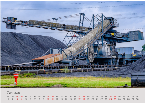
Kohlelager für das STEAG-Kraftwerk
