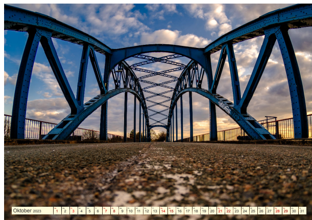
Bassinbrücke Eisenbahnhafen in Duisburg-Ruhrort
