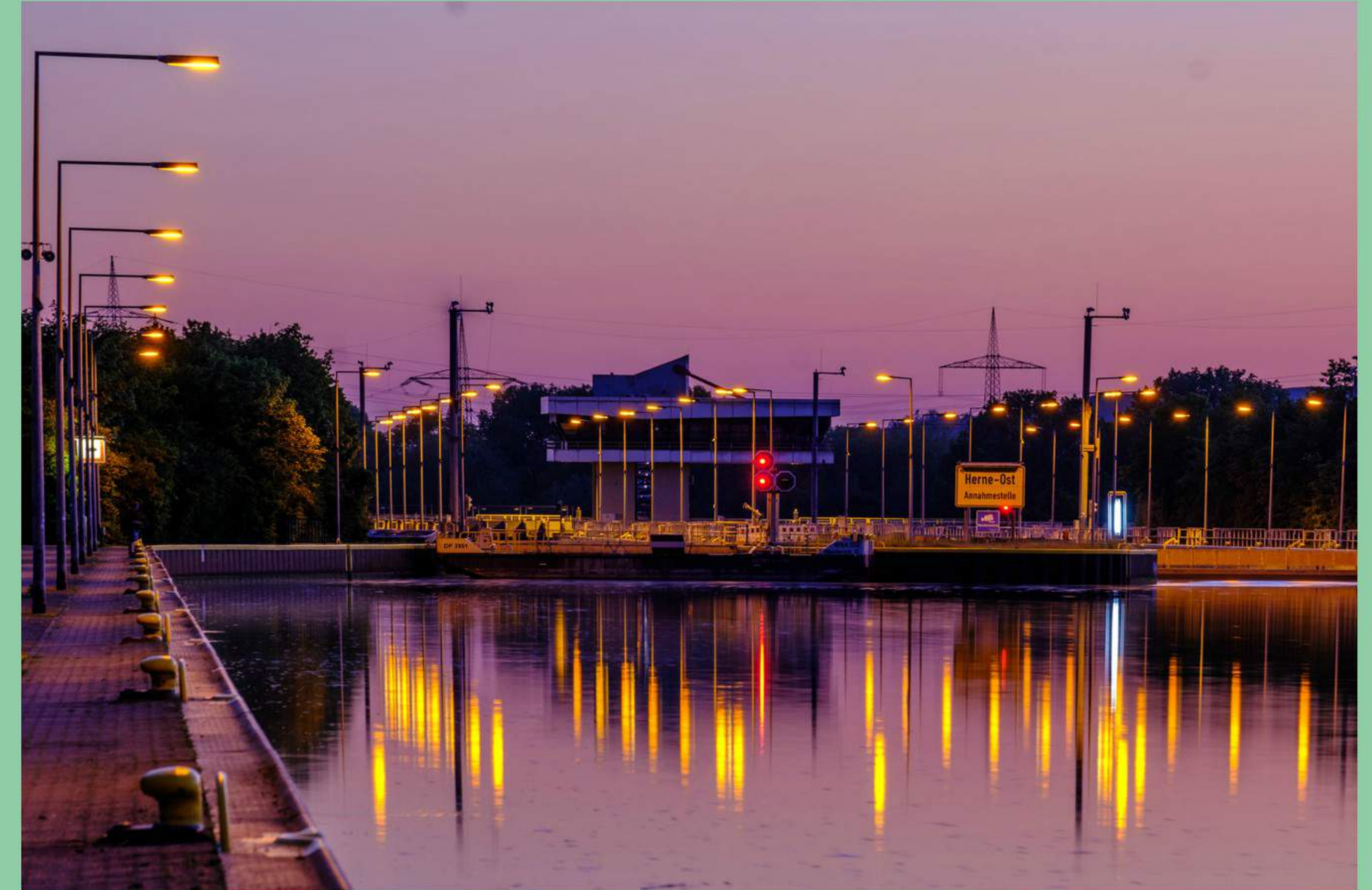
Schleuse Herne-Ost (Blick von östlicher Seite)
