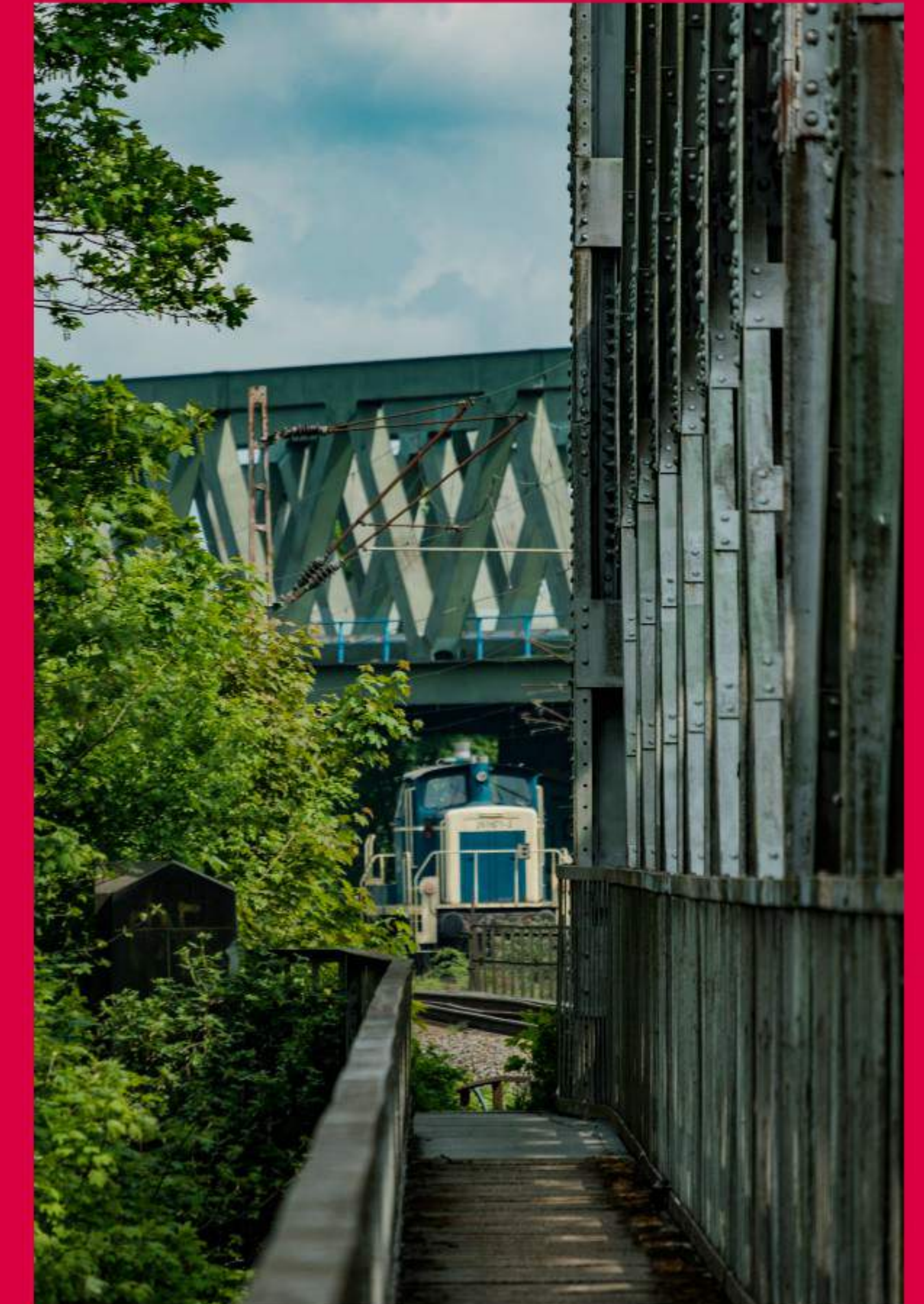
Eisenbahnbrücke mit Fußgängerübergang
