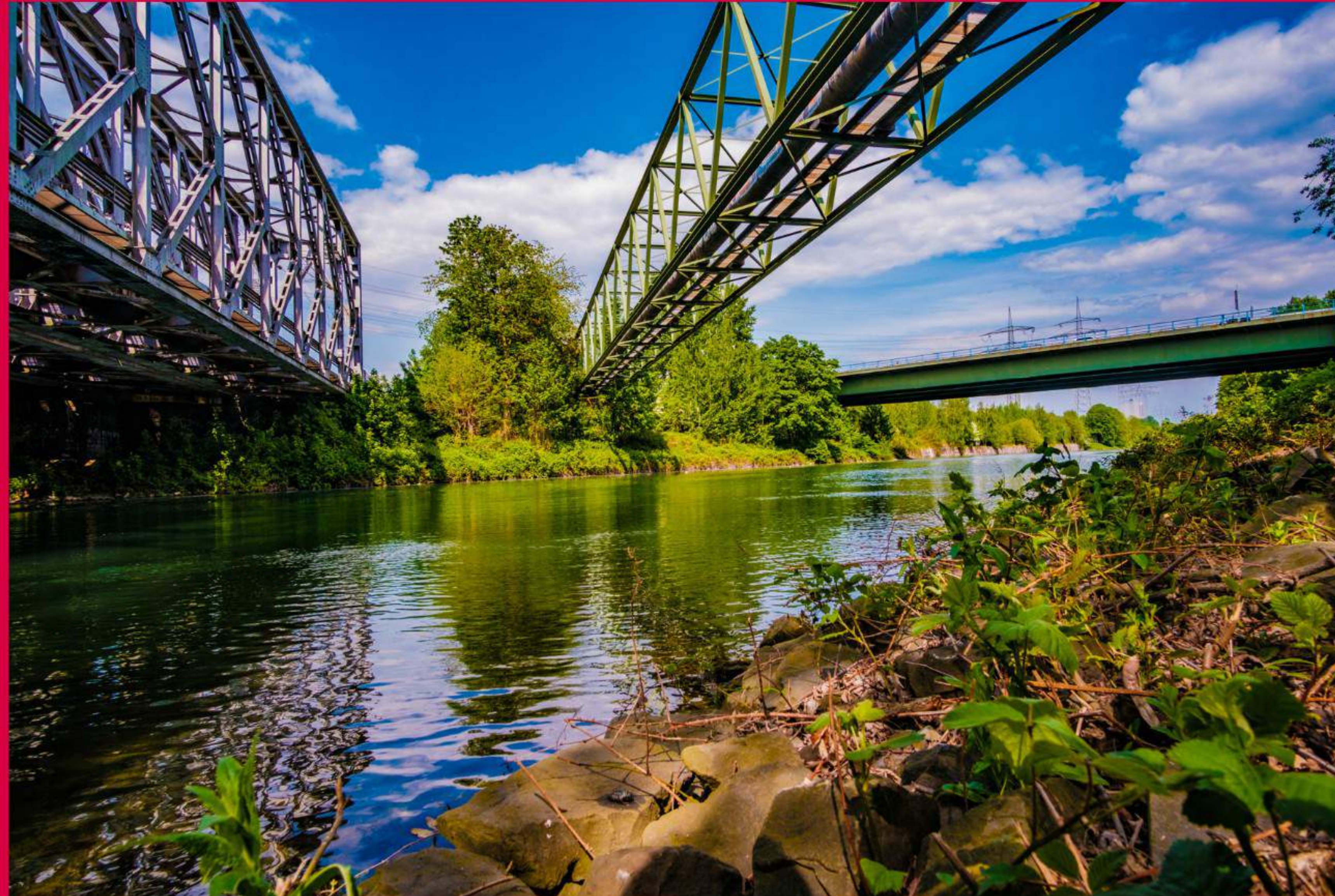
Dieses Bild zeigt - von links - Eisenbahnbrücke, Fernwärmeleitung der STEAG, Autobahn A43
